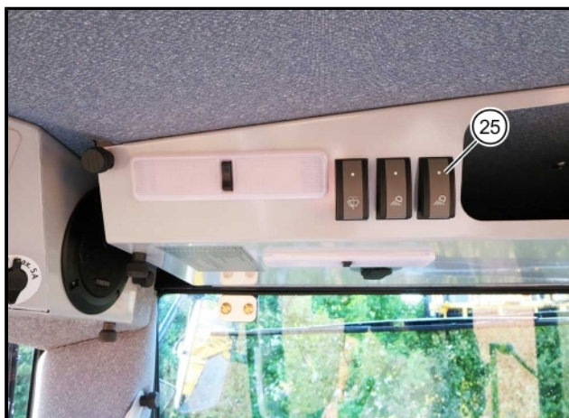
Schalter für die Aufstiegsbeleuchtung in der Dachkonsole
